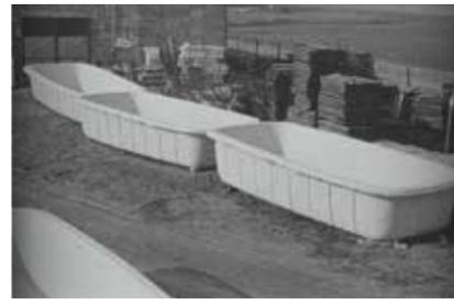
Die ersten Leidenfrost Schwimmbecken werden in Glasfaserverbundbauweise gefertigt.
