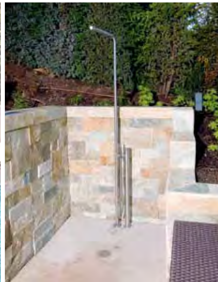
Stützmauern sichern den Hang hinter dem Pool. In der Nische davor ist eine Außendusche von Vola untergebracht. www.vola.com
