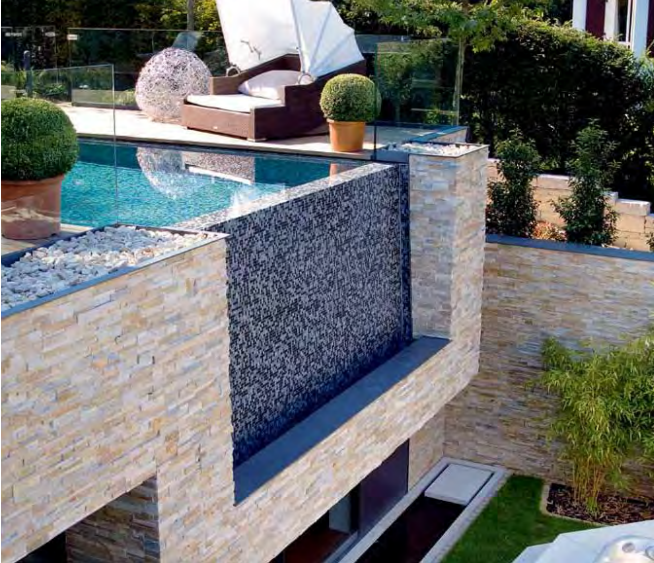
Hangabwärts fließt das Wasser über die Mosaikwand in die tiefer liegende Auffangrinne. So ist der Außen-Pool auch im Lichthof der Schwimmhalle wahrnehmbar.
