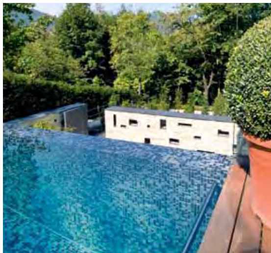
Hangabwärts fließt das Wasser über die Mosaikwand in die tiefer liegende Auffangrinne. So ist der Außen-Pool auch im Lichthof der Schwimmhalle wahrnehmbar.
