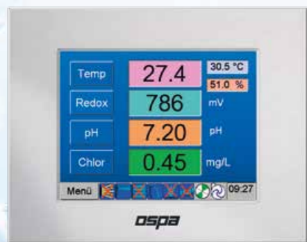
Anbindung der Klimaanlage: Einstellung und Anzeige der Raumtemperatur und Raumfeuchte.
